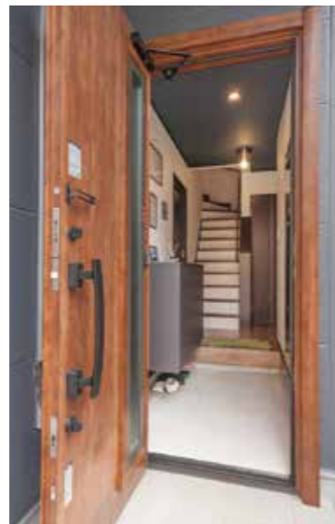
屋根外壁塗装をして、採風可能な玄関扉に取替え
