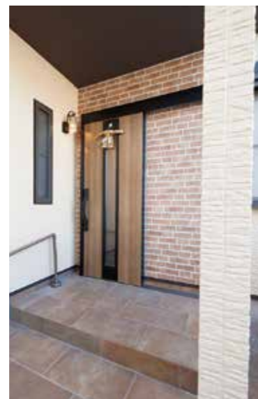
屋根外壁塗装をして、システムキーを搭載した玄関扉に取替え
